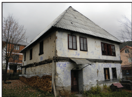
Kuća Safeta Feleća
