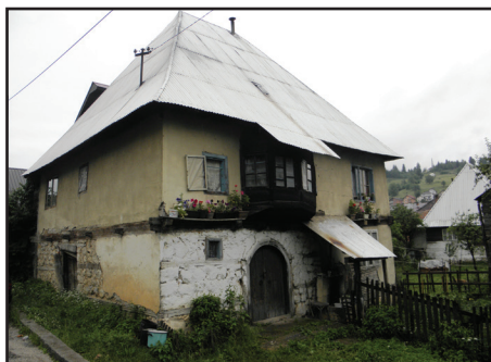
Kuća Ćamila Topalovića
